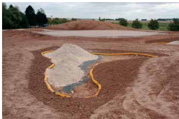
↳ Golf de Saint-Aubin (91) - Création d'un green et d'un bunker Architecte : © Robert Berthet
