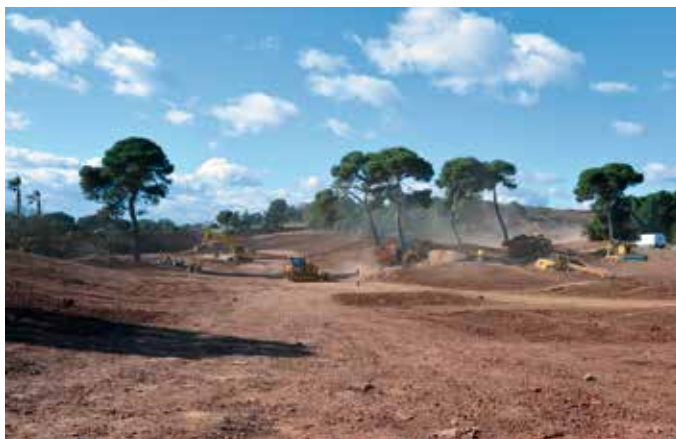
Trou n°7 en début de chantier (2013)
